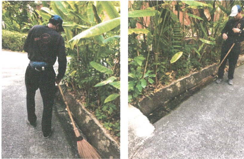
รูปภาพที่ 2.5 การทำความสะอาดรางระบายน้ำ/ท่อระบายน้ำ
