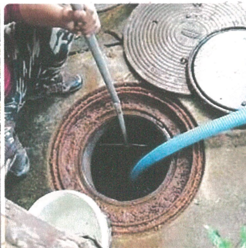
รูปภาพที่ 2.4 การสูบน้ำตะกอน/ไขมัน
