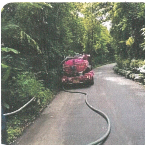
รูปภาพที่ 2.4 การสูบน้ำตะกอน/ไขมัน
