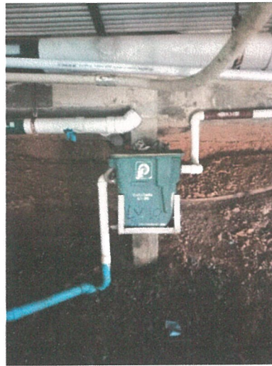
รูปภาพที่ 2.2 ระบบบำบัดน้ำเสียสำเร็จรูปของโรงแรม
